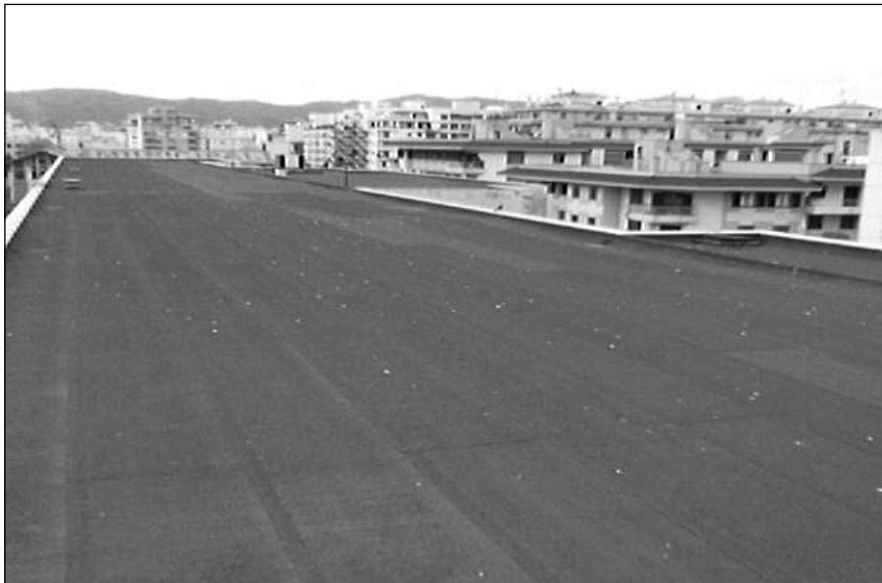
Immens terrat de l'IES Josep Mª Llopart. Les possibilitats d'instal·lació i d'orientació de plaques fotovoltaïques, com es pot comprovar, són immillorables en aquest centre. El mateix passa a la majoria de centres educatius de les illes.
