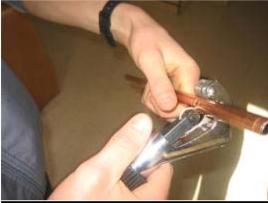
Se marca y se cortan los tubos de cobre con el cortatubos.
