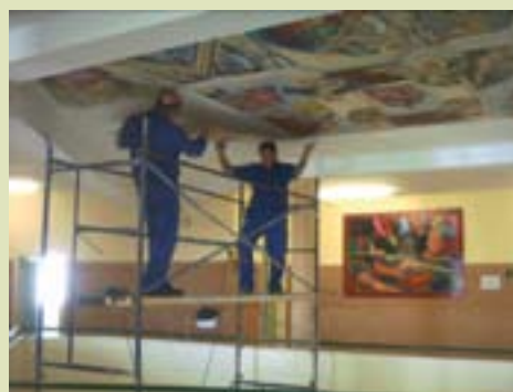
■ Instalación de los paneles sobre el techo con apoyo de los montadores (Antonio Carmona y Manuel González)
