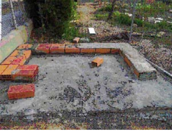
Fase 1: cimentación de la solera
