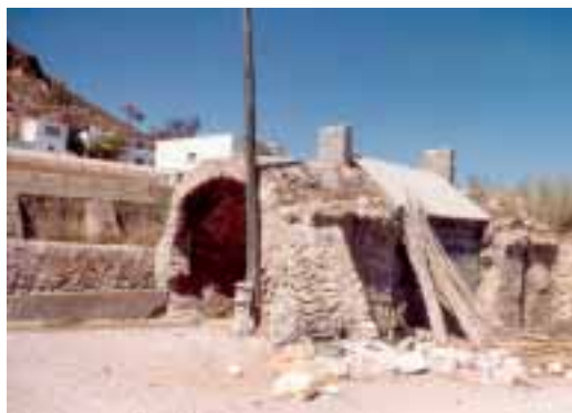
Vista exterior de los baños de Benejí.
