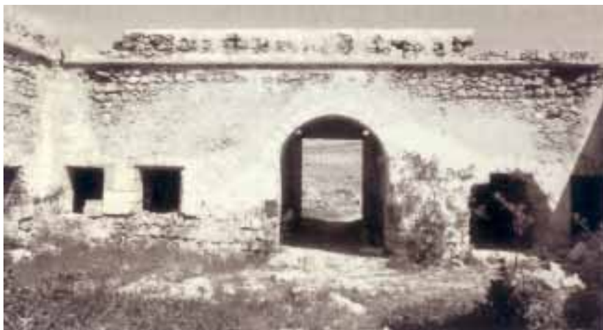
Vista del patio interior.
