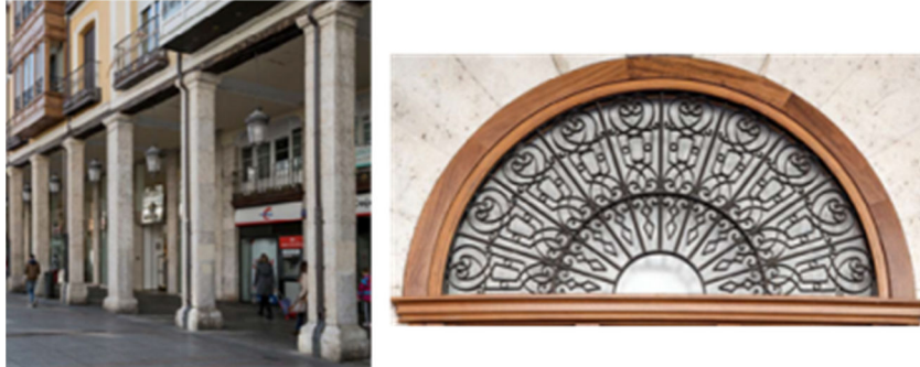
Figura 12. Columnas en la calle y parte superior de una puerta
